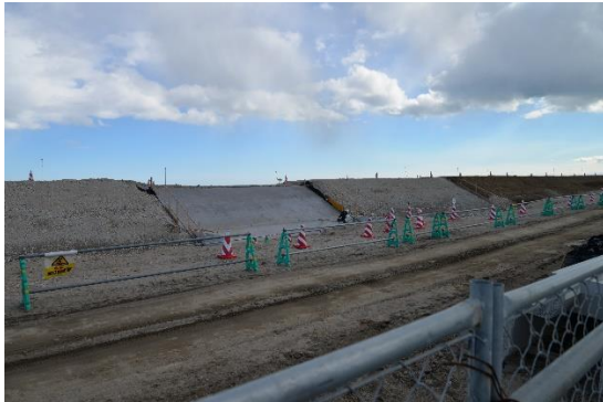
津波防潮堤建設がすすんでいる。ここでは高さが7.2mあり、海は見えない。
